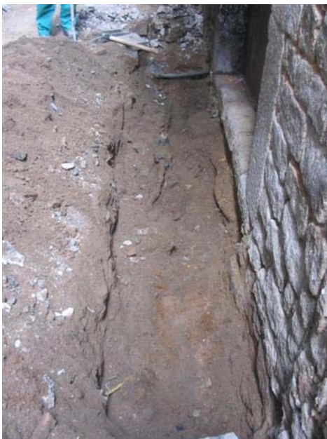
FOTO 1. Vista de la cala 1.
