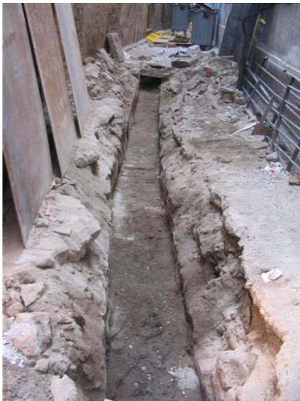
FOTO 4. Vista del col·lector central del carrer Mosques
