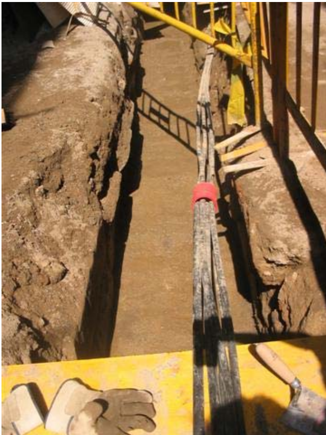
FOTO 3. Detall del col·lector central del carrer Cirera
