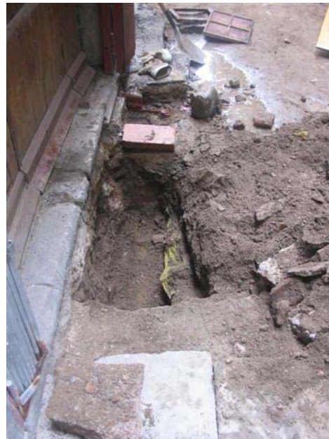
FOTO 2. Vista de la cala 2.
